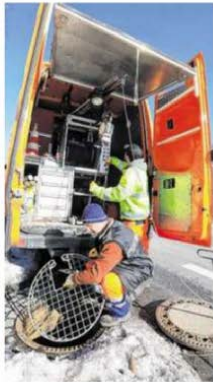
Bernd Günther öffnet den Kanaldeckel und überprüft mit seinem Kollegen Emanuel Pane von der Firma Dorr das Kaufbeurer Kanalnetz in der Apfeltranger Straße. Dazu lassen sie eine Kamerasonde in die Tiefe hinunter. Im Transporter verfolgt Günther die Kamerafahrt im Untergrund am Bildschirm.
