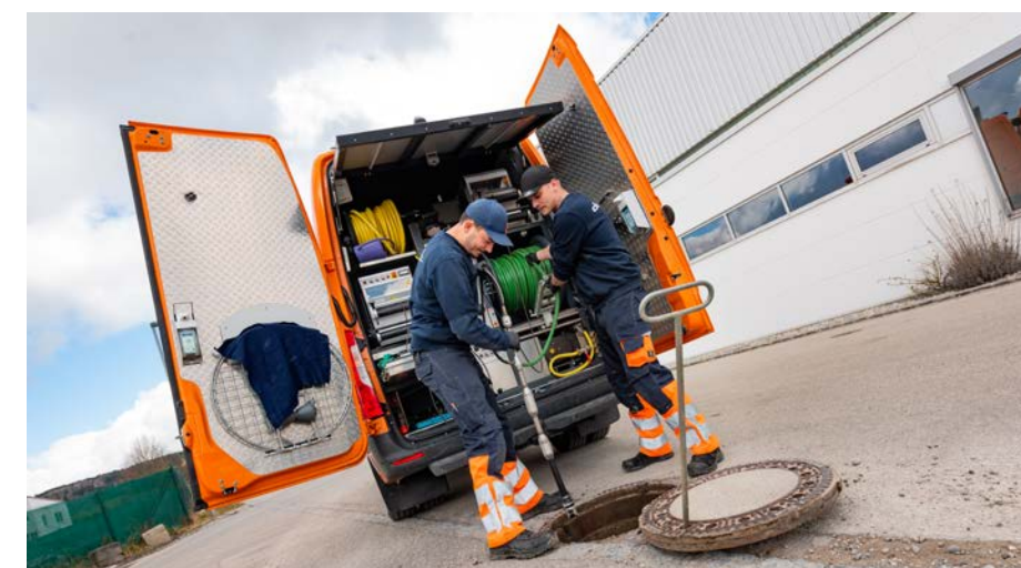
Dichtheitsuntersuchung eines Kanals mittels moderner und geeichter Prüfsysteme.
